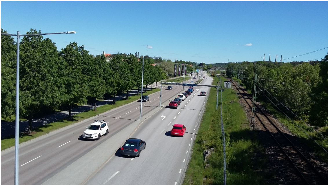
Göteborgsvägen norrut sedd från befintlig gång- och cykelbro.
